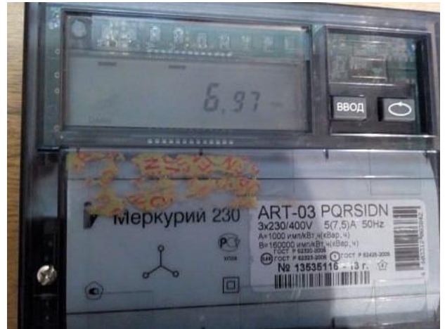
Рисунок 3.8– Трехфазный электронный счетчик Меркурий 230
